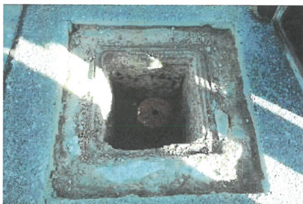
Obr. 6: Šachta pozor. vrtu na koruně hráze (závada č.3)
