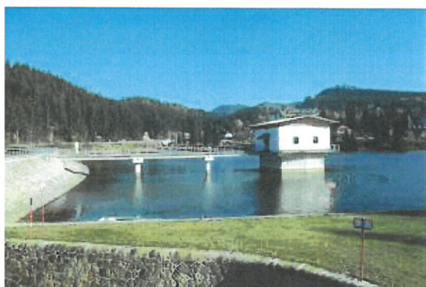
Obr. 4: Věžový objekt a předpolí bezpečnostního přelivu
